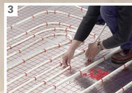
Nach Anschluss der Rohre und Überprüfung ihrer Dichtigkeit wird der Estrich, der ein Zusatzmittel beinhalten muss, aufgebracht – fertig!
