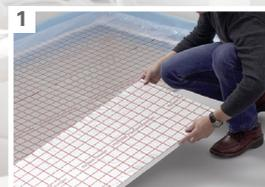
Die Systemplatten werden nun mit einem Aluminiumklebeband sorgfältig miteinander verklebt.
